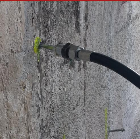
Elément de liaison entre les injecteurs à tête plate et le tube de pompage des pompes manuelles ou électriques, utilisé pour bloquer les infiltrations d'eau par injections de résines polyuréthanes hydroréactives.
