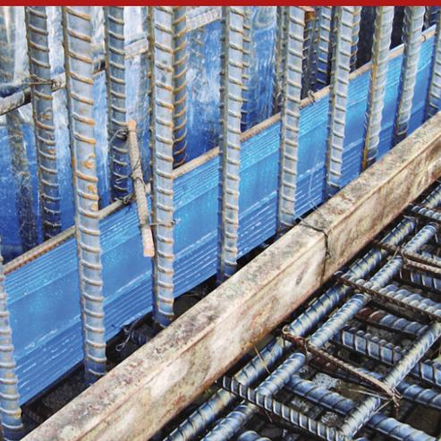
Le waterstop Sealpvc RG 250 est un profilé en PVC imperméable, non hydro-expansif, de 25 cm de large doté de grande élasticité. Il est utilisé dans les joints statiques horizontaux (dalles) ou verticaux (murs d'élévation) des structures en béton, en position centrale dans la coulée.
