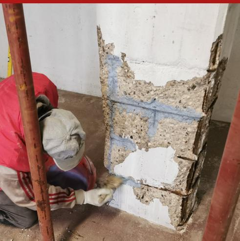
Coulis cimenté à un composant en poudre, passivant, de couleur bleu clair, à ajouter à l'eau, modifié avec des agents superpouzzolaniques, résines de flexibilisation et d'anticorrosion pour le traitement passivant des barres d'armature oxydées, dans la restauration de béton endommagé.
