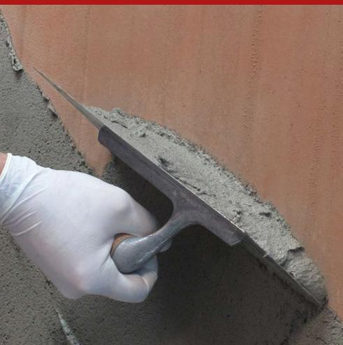
Ciment de ragréage structural thixotropique, fibro-renforcé, ayant de parfaites caractéristiques d'adhésion, de résistance à la compréhension, à la flexion, à l'abrasion, etc. Idéal pour les interventions d'assainissement structurelle d'ouvrages et de manufacturés en béton dégradé. Applicable à la truelle et à la taloche.
