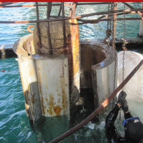
Mortier composite, coulable, antidélavant, à retrait contrôlé, à consistance superfluide, à base de ciment à haute résistance, charges superpouzzolaniques (MICROSIL 90), modificateurs polymères, agents anti-retrait, additifs spécifiques, fibres minérales en silicate de calcium, granulats siliceux sélectionnés.
