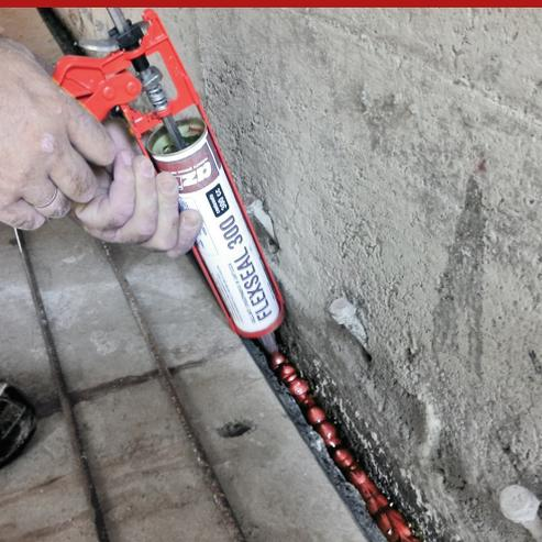
Scellant polyuréthane hydro-expansif en pâte thixotropique, préemballé en cartouches extrudables avec des pistolets de distribution normaux, à utiliser comme waterstop dans les situations les plus complexes ou inconfortables d'imperméabilisation de locaux souterrains. Il conserve ses propriétés d'élasticité et d'étanchéité inaltérées dans le temps. Dans un état complètement sec, Flexseal 300 rétrécit à sa taille d'origine, puis se dilate à nouveau au contact de l'eau.
