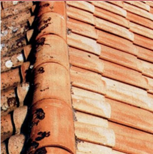
Consilex Jazz est une dispersion aqueuse de résines polysiloxanes, idéale pour donner aux objets traités, par le biais d'une pulvérisation à jet à basse pression, des caractéristiques hydrofuges et revitalisantes.
