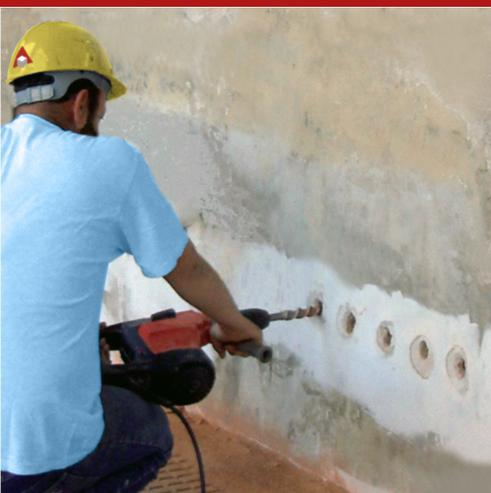
Système à composant unique à base de silanes modifiés pour la préparation, avec le seul ajout d'eau, de microémulsions hydrophobes pour injections murales, à diffusion lente, contre la remontée ramifiée d'humidité, spécifiques pour la construction de barrière chimiques dans les maçonneries en briques, tuf, pierre et mélanges, de différente épaisseur.
