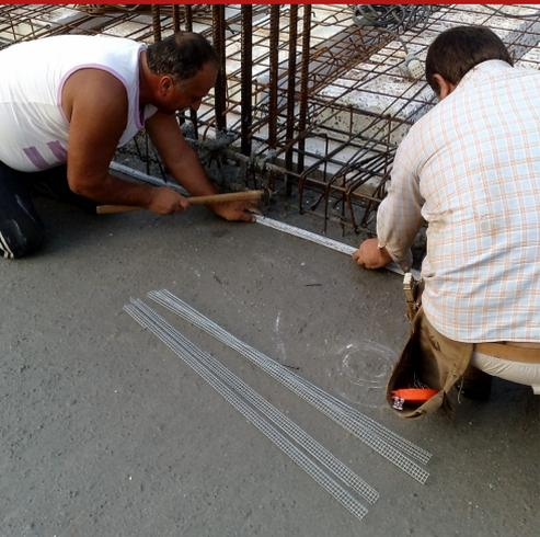
Petite cage en toile d'acier à maille carré, de forme trapézoïdale ouvert d'un seul côté, de forme pré-définie, à utiliser pour favoriser le positionnement correct des lames d'étanchéité en bentonite sodique Clayseal 25.20, et en empêcher le déplacement de sa place prévue, spécialement en situation complexe ou sur des surfaces imparfaitement préparées. Bentonet, une fois inséré le joint devra être fixé au support en béton, à l'aide de clous d'acier et rondelles tous les 20-25 cm.
