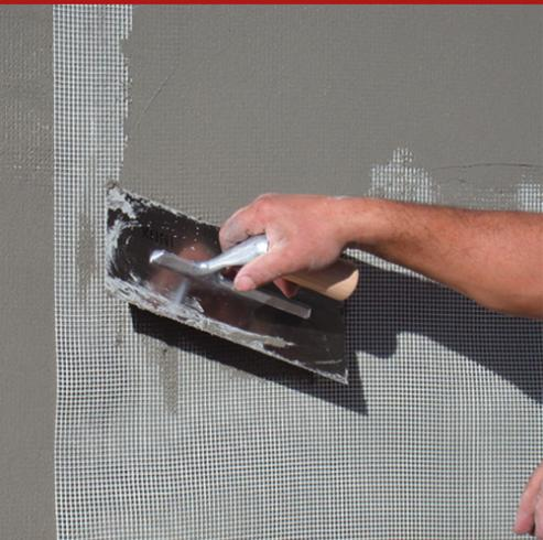
Treillis de renfort anti-fissures, à base de fils de fibres de verre résistant aux alcalins, pour une meilleure répartition des contraintes et pour éviter les fissures de retrait causées par les variations de température, les irrégularités des plans, etc.. D'un poids de 160 g/m<sup>2</sup> et d'une taille de maille carrée de 4.5 x 4.5 mm, l'Armaglass 160 est la maille en fibre de verre idéale pour la réalisation d'enduits d'étanchéité renforcés.
