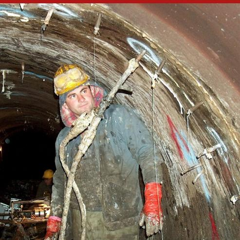
Résine polyuréthane monocomposante semi-flexible, hydroexpansive (pour augmenter 20 fois environ le volume initial), sans solvant, idéal pour l'étanchéité par injection, grandes et petites infiltrations d'eau dans la maçonnerie en béton ou solide en général. Idéal pour combler de grands vides et les vides sanitaires pour les murs intérieurs.
